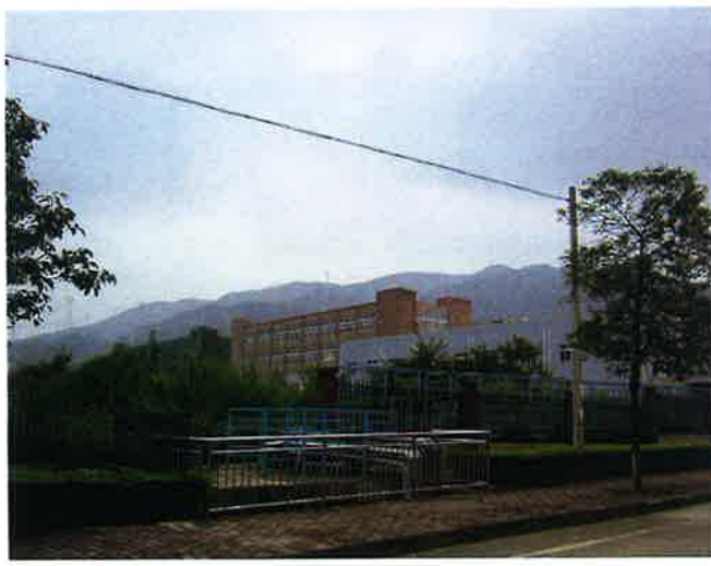
大規模な汚染処理場(写真手前)を有する清遠市龍湾電鍍定点基地
