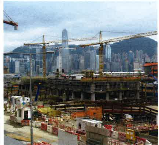
広州—香港間高速鉄道の駅が建設されている西九龍
