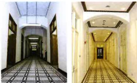
改修前の廊下（左）は天井に穴が空いている。改修後はエアコンを設置したため横の梁が細くなっている。改修前と同じデザインの穴をあけ、そこから冷気を逃している。
